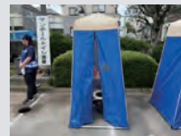
マンホールトイレ
